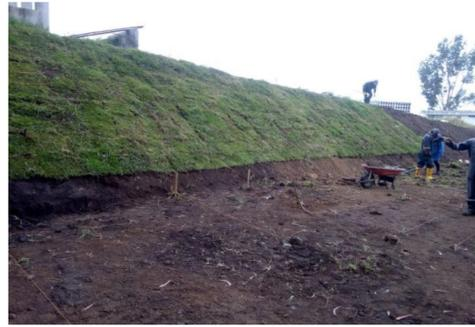
Fotografía 4. Trasnpprte y colocación de chambas en los 3 taludes del cementerio
