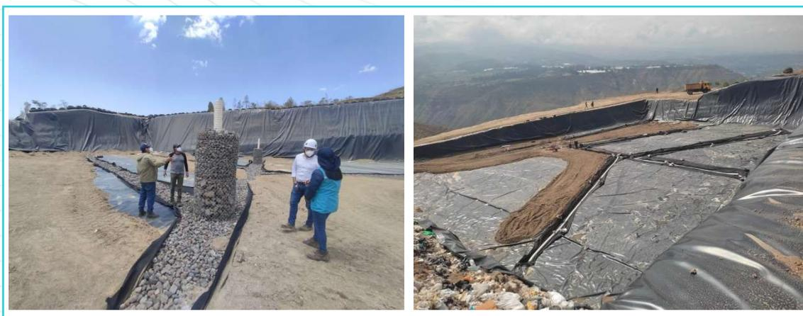
La ampliación de la tercera celda del relleno sanitario ha sido diseñada bajo criterios de ingeniería sanitaria que consideran aspectos como: impermeabilización del fondo con geomembrana de polietileno de alta densidad para prevenir la infiltración de lixiviados hacia el subsuelo, drenaje de lixiviados mediante una red de tuberías perforadas colocadas sobre una capa de material granular, y sistemas de captación de gases generados por la descomposición anaeróbica de los residuos orgánicos.
