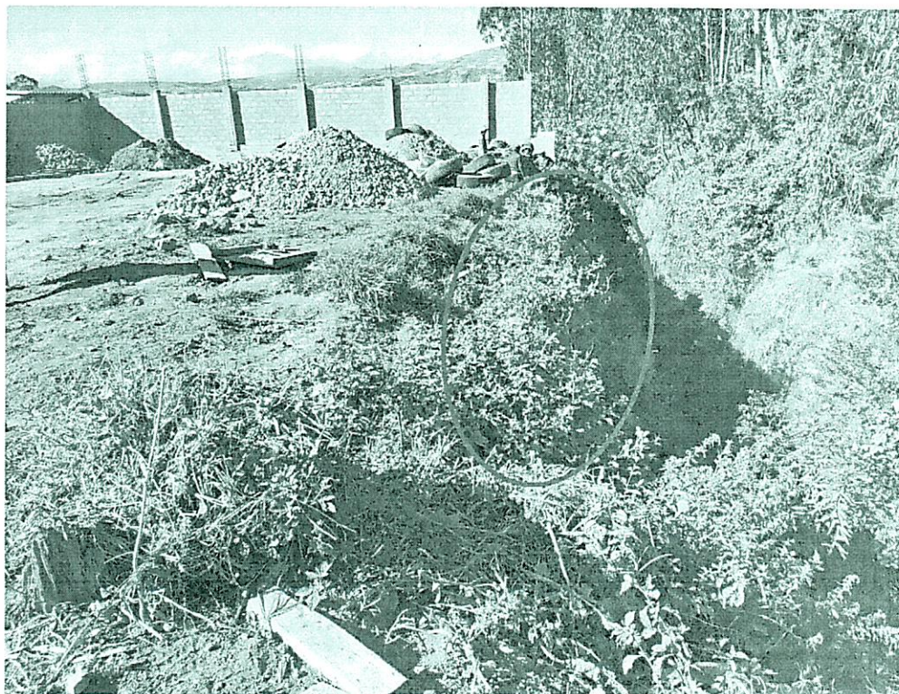
Figura A1.3 Construcción del muro de contención
